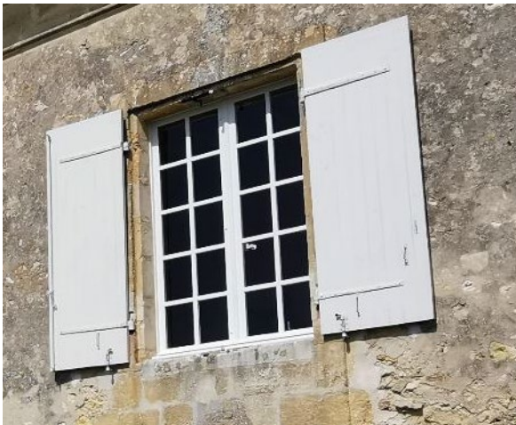
Fenêtre à petits carreaux et à espagnolette, contrevents pleins
