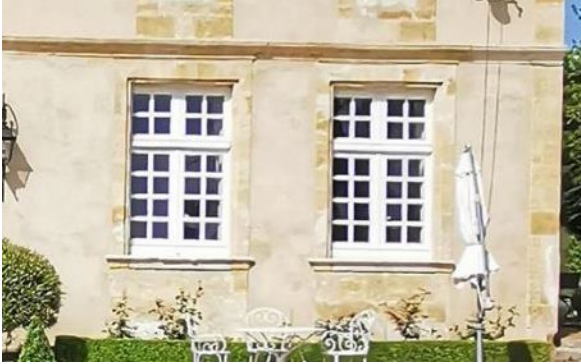
Fenêtres à croisée en bois et à petits carreaux.
