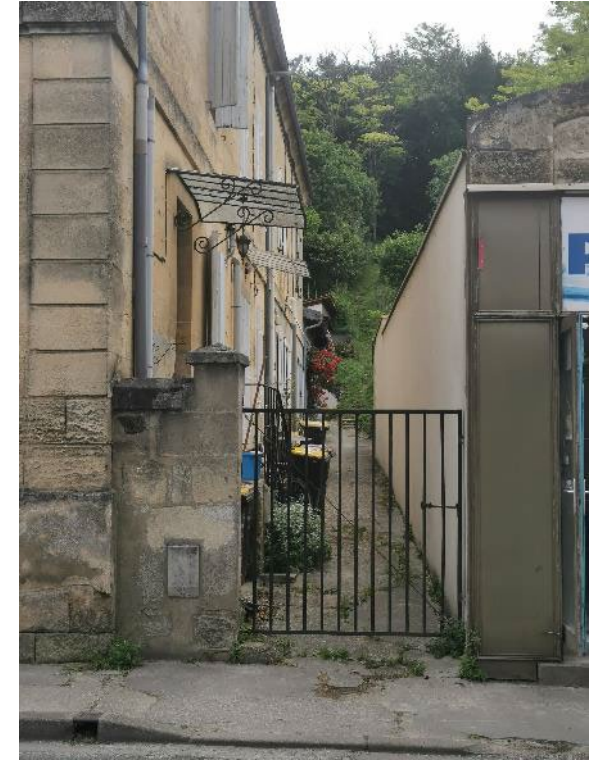
Courettes sur un ancien passage, servant à entreposer les poubelles
