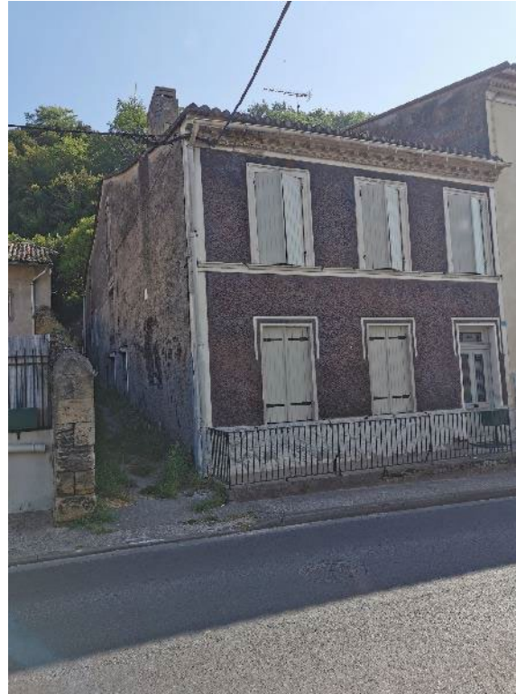
Avant-cour créant un espace de transition avec la voie publique
