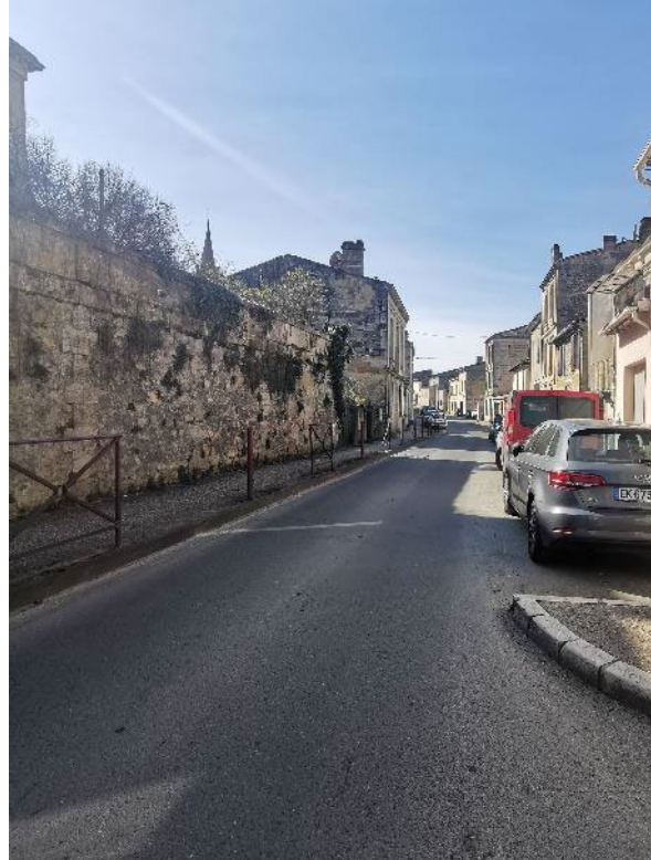
Des murs en pierre dans la continuité du bâti
