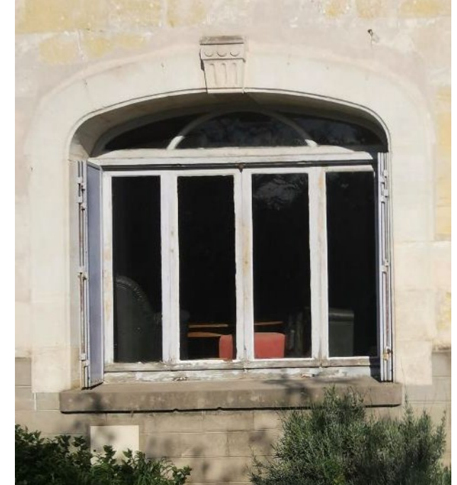
Baie vitrée avec imposte à petits bois
