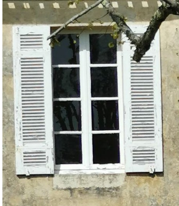
Fenêtre à grands carreaux et contrevents à persiennes
