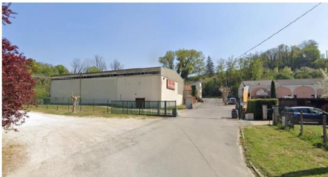
Bâtiments vacants à démolir
